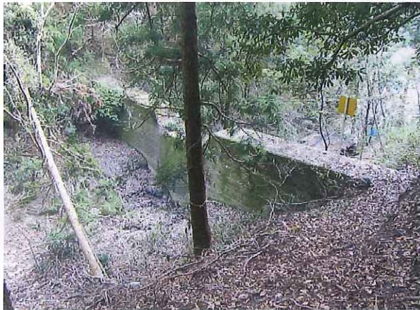
既設堰堤上流より撮影
